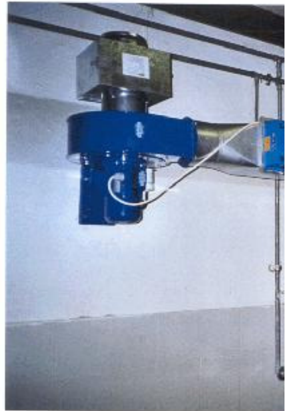
Elektronische Geruch Fettabscheider Hotel Palace Robins
